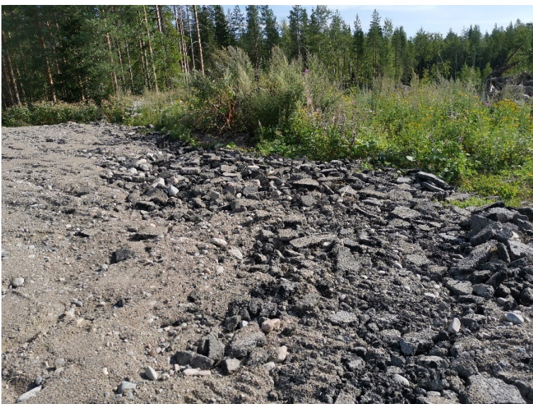
Kuva 7 ja 8. Aiemmin kentän pinnalla olleet isot asfalttipalat on jätetty sorakerroksen alle, sorapintaisen kentän reunasta näkyy vielä asfalttia. Mittakuva silmämääräisesti arvioituna keskikokoisesta kappaleesta.
