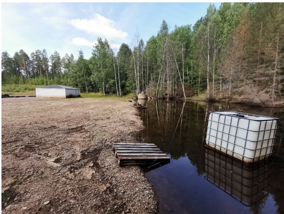
Kuva 6. Kartingradan pohjoisreunaan muodostuvan pohjavesilammikon tilanne kesällä 2026.
